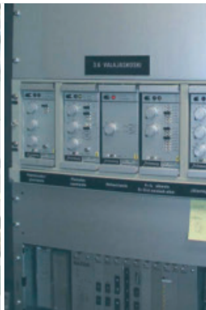
Releiden kolme sukupolvea: sähkömekaaninen, staattinen ja digitaalinen rele.
