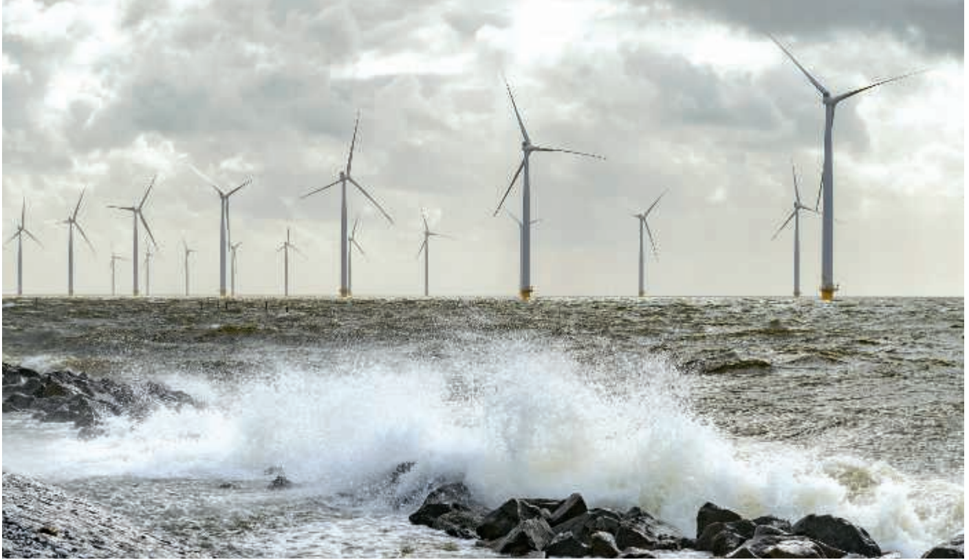
Tuulivoimalat pysäytetään kovien myrskyjen aikana, kun tuulenopeus nousee pidemmäksi aikaa 25–30 metriin sekunnissa. Suomessa tällaisia myrskyjä on harvoin.
