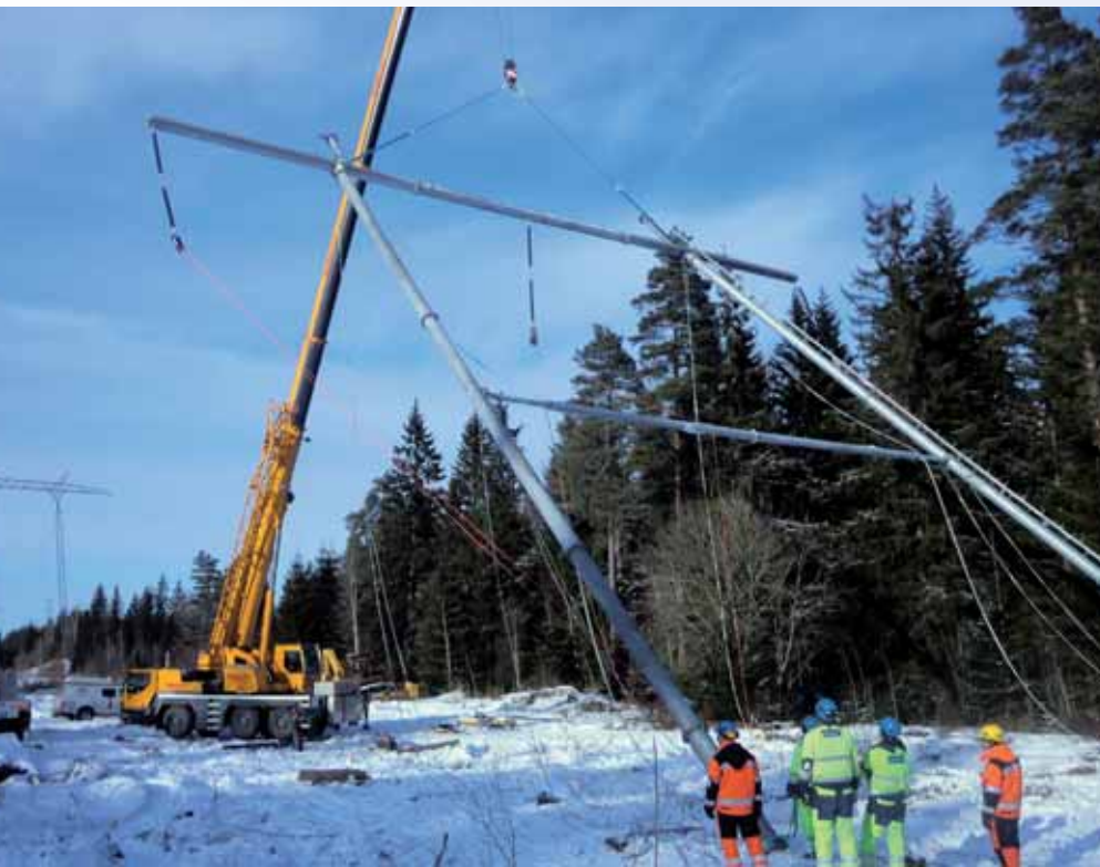
Fingrid toi Åsbron harjoitukseen 400 ja 110 kilovoltin viankorjauspylväät. Kuvassa pystytetään 400 kilovoltin pylvästä.
