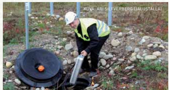
KUVA: ARI SILFVERBERG (JALUSTALLA) Ari Silfverberg tarkastamassa Norjan-yhteyden valokaapelijatkosta Utsjoella.
