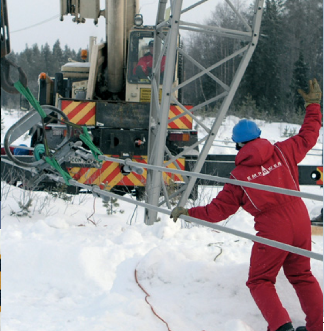
Alumiinipylvään johtimet lasketaan alas ennen pylvään kaatamista.
