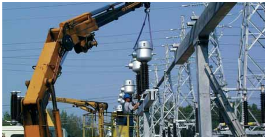
Kojeiden asennus sähköasemalla vaatii tarkkuutta ja ammattitaitoa.
