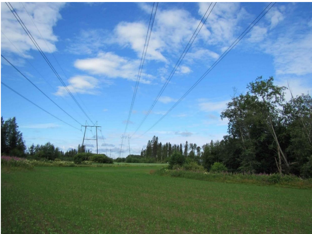
Kuva 6-3. Olkijärvi-Raahe voimajohto ylittää peltoalueita. Tässä Saarelanperän alueella reittivälillä C-D. Suunniteltu voimajohto rakennetaan nykyisten voimajohtojen pohjoispuolelle, eli kuvassa oikeanpuoleisen johdon viereen, jolloin johtoalue levenee noin 24 metriä.
