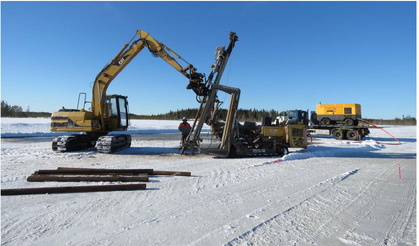
Kuva 6. Porapylväsraudoituksen tekoa suoalueella, missä työalue on jäädytetty.
